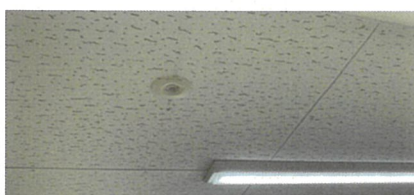
感知式センサー設置による電力無駄使いの防止
