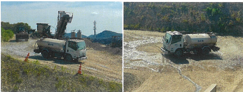
粉塵防止のための散水作業
